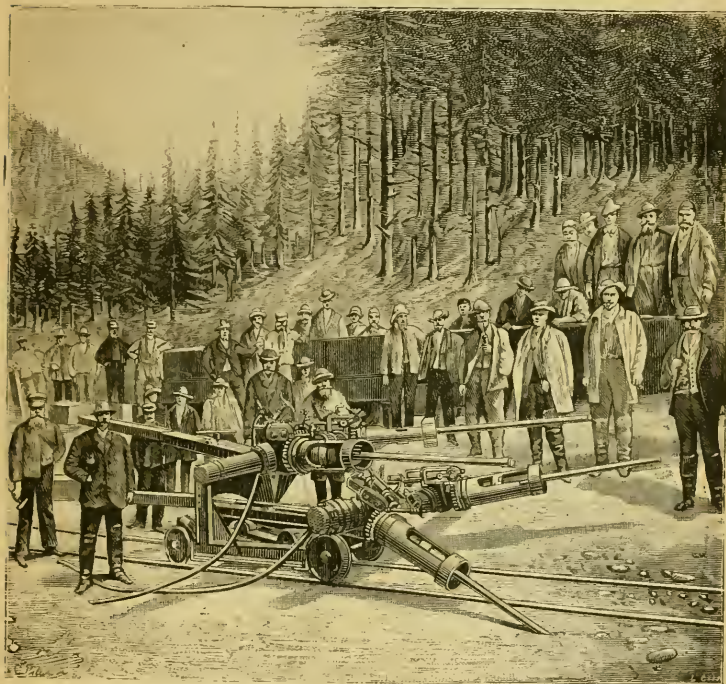
FIG. 131. — MACHINE DE BRANDT À 4 FORETS, EMPLOYÉE AU PERCEMENT DU TUNNEL DE L'ARLBERG (CÔTÉ OUBST)
